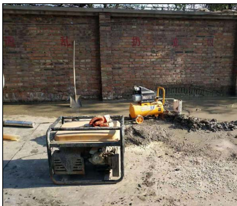
图 4-5 抽水试验现场图片
