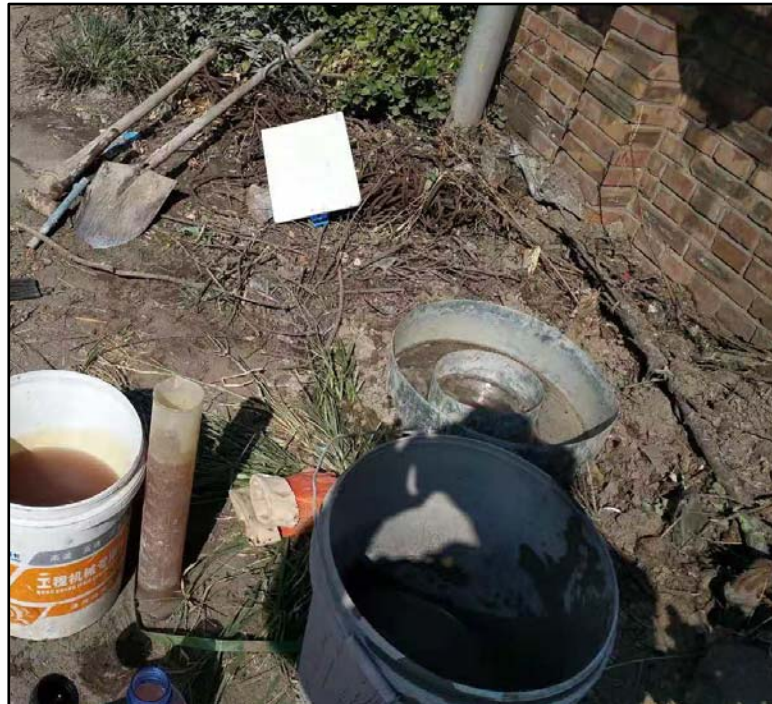
图 4-8 本项目渗水试验现场图片
