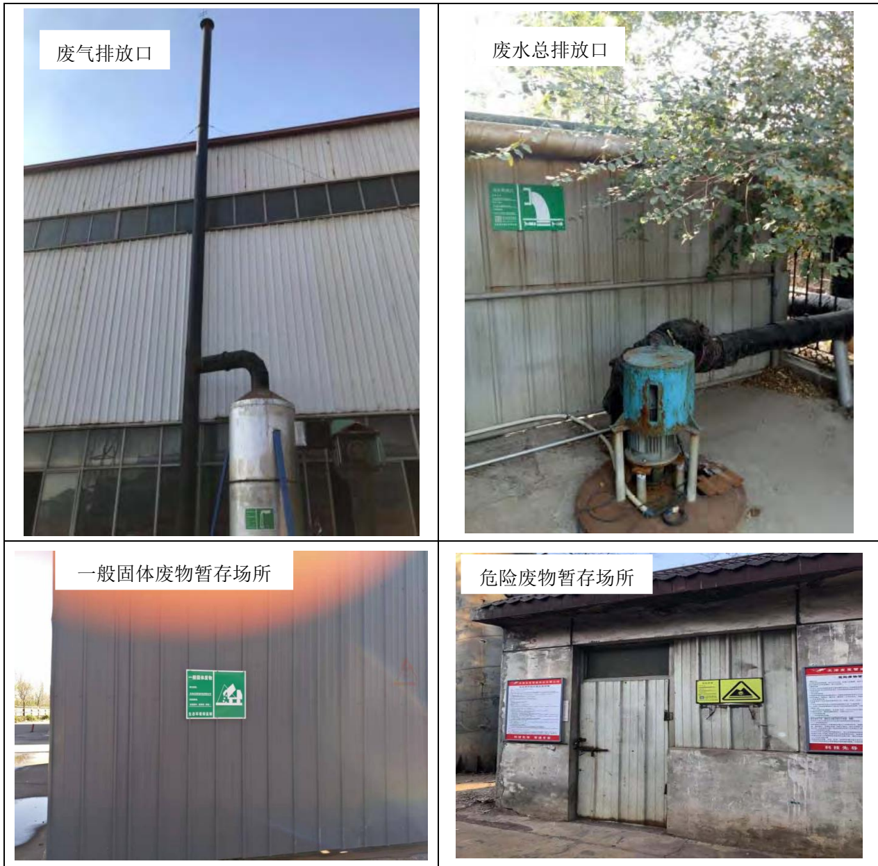
图2-6 现有工程排污口规范化照片
