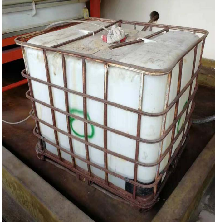
图 6-3 氨水桶存放及其向设备补加氨水接口处理实例图片
