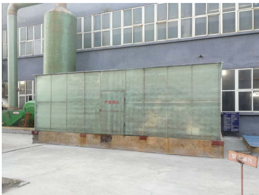
图 2-1 本项目盐酸储罐现状照片
